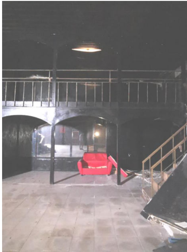
Foto 4: Ambiente interno adibito a Night Club (soppalco da demolire)
