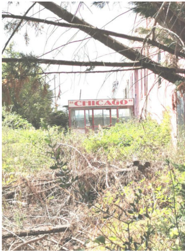
Foto 2: Accesso all'UI. Pignorata dal lato Nord del capannone
