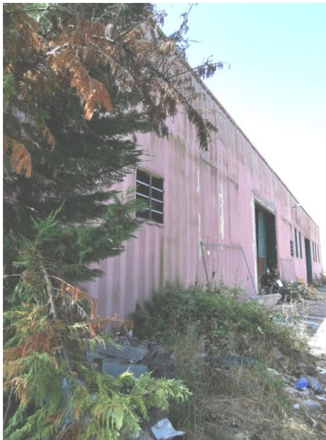
Foto 1 : Capannone “C” di cui l’U.I. pignorata fa parte.
