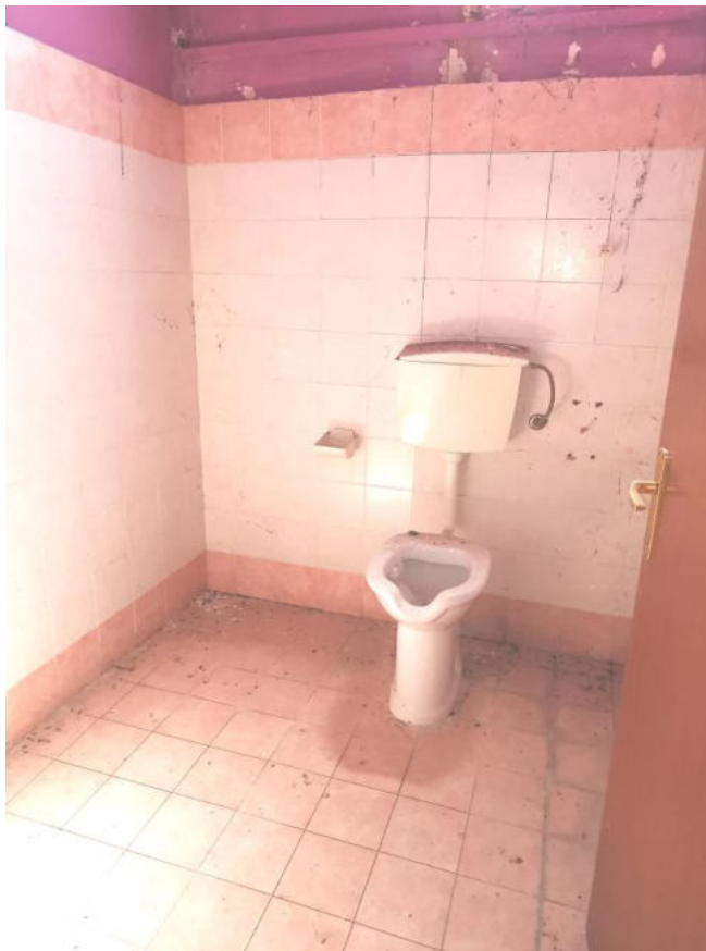
Foto 6: Servizi igienici all'interno del locale
